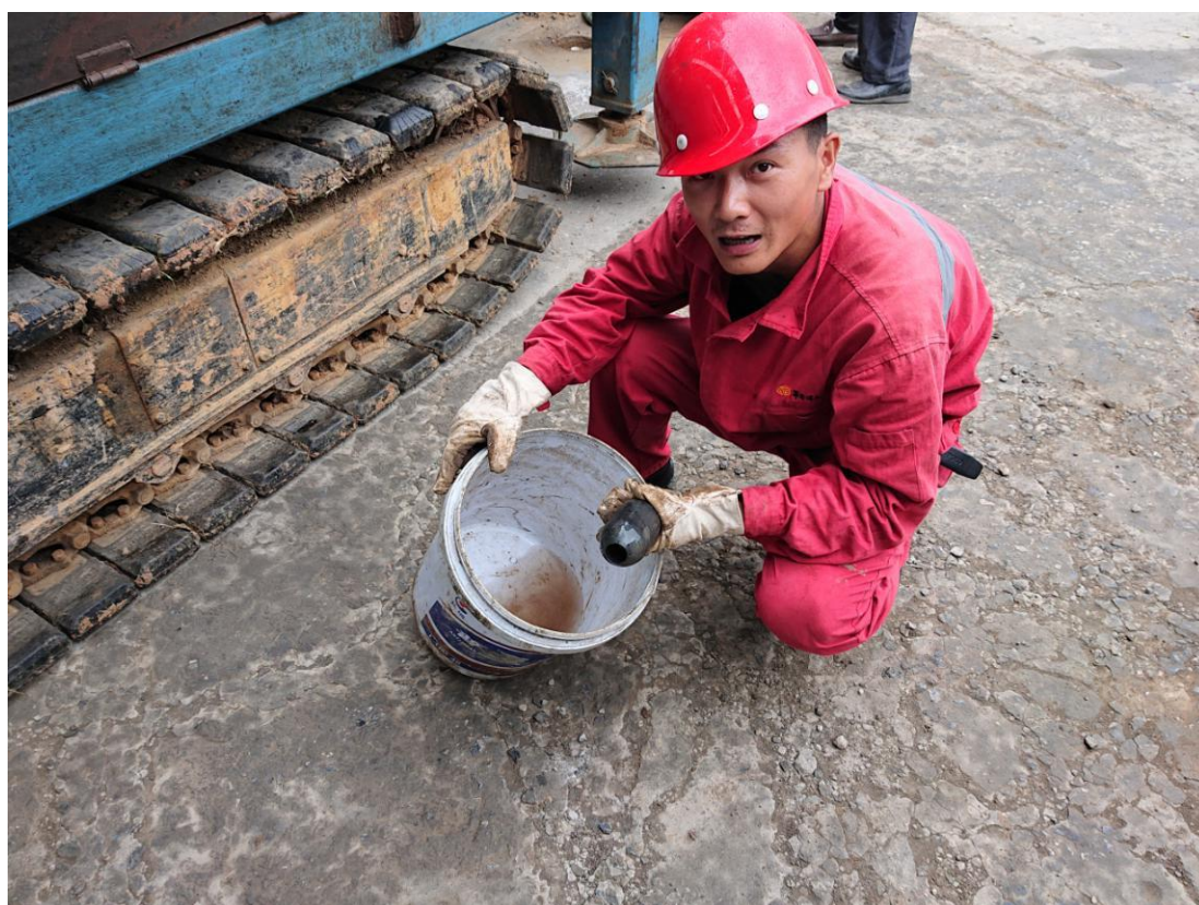
图 4-1 钻具清洗照片
