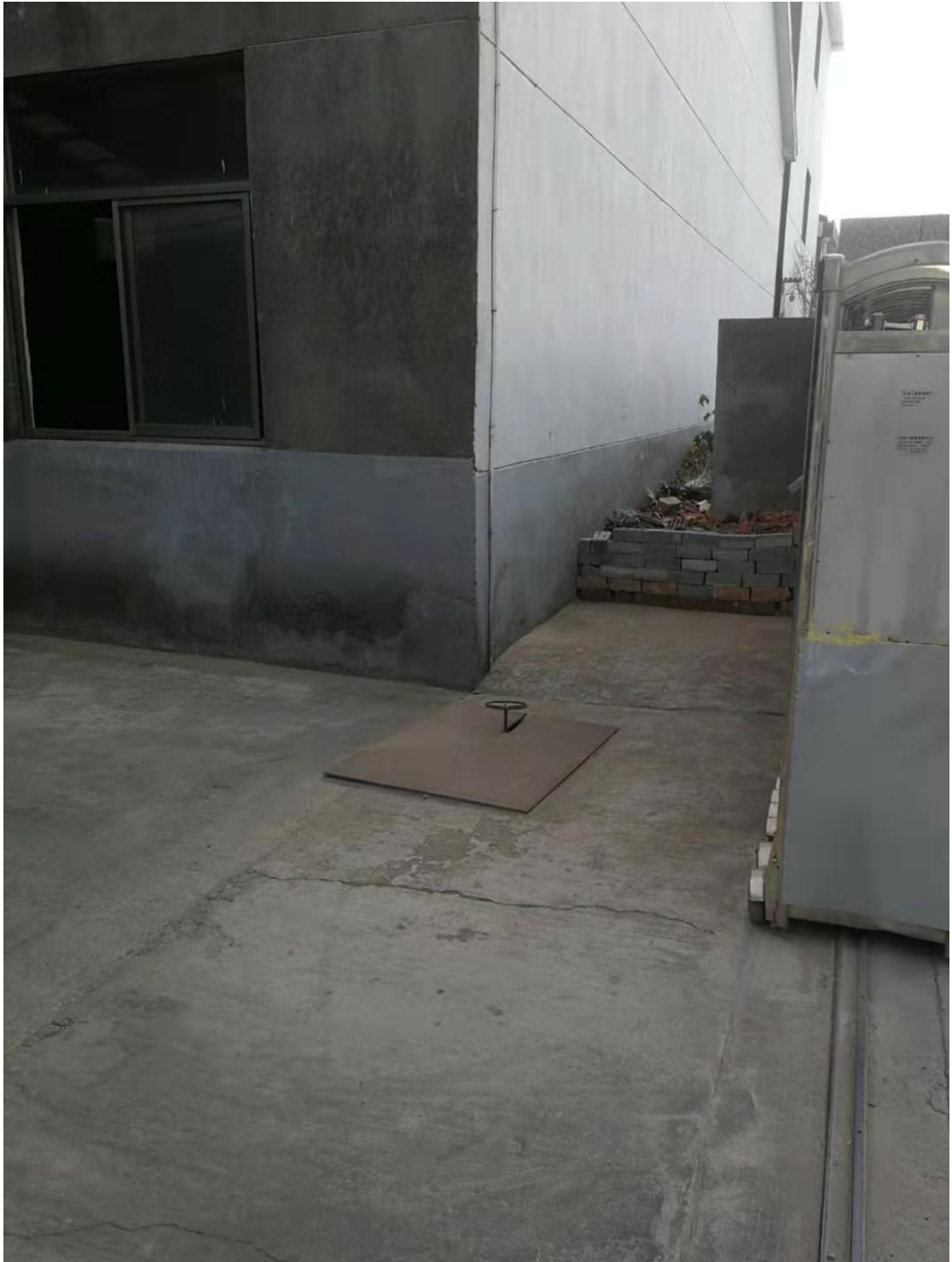
图 1.3-4 全厂雨水收集外排口
